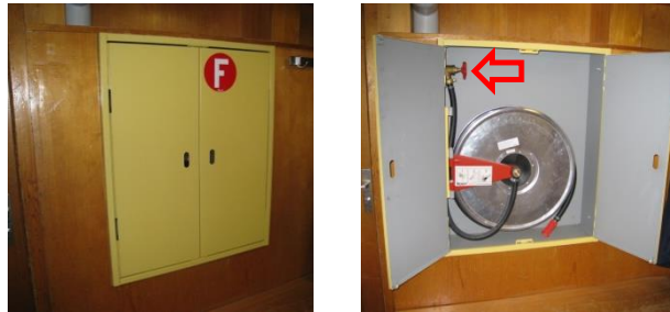
Bild: Löschposten in der Garderobe EG.
